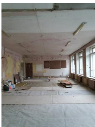
Идет ремонт конкурсной площадки, кабинет № 32
